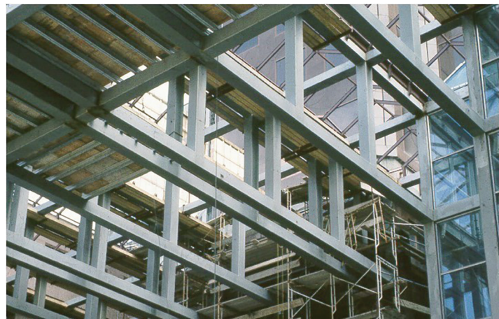
Fig. 10-1. Vierendeel frames using rectangular HSS.
