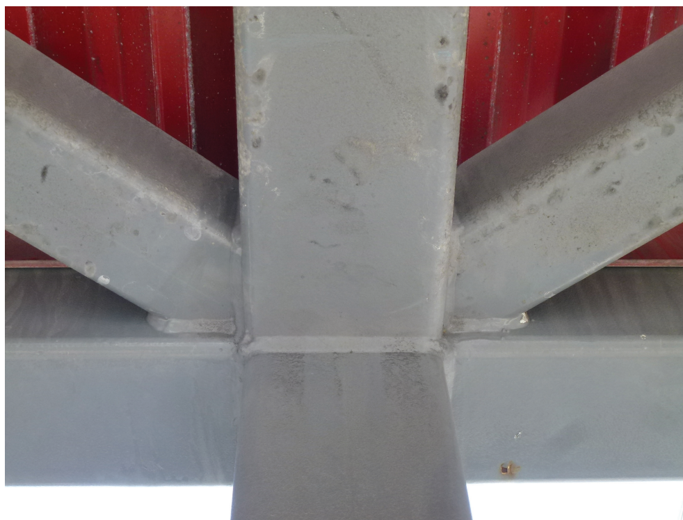
Fig. 9-7. HSS KT-connection.
